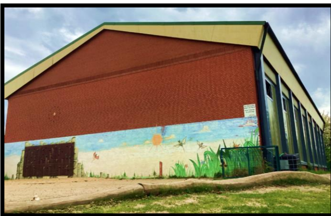
Die Turnhalle soll auch noch renoviert werden.
